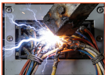
● 電線捆綁或者被重壓, 熱量無法逸散從而短路引發火災隱患
